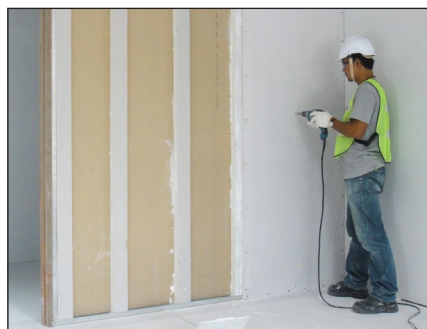
5. ติดแผ่นโซลิดวอลล์เข้ากับโซลิดสตัด ยึดด้วยโซลิดสกรู
