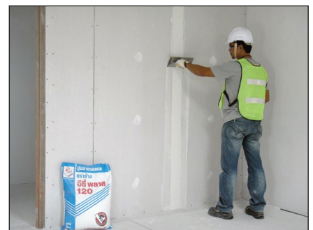
6. ฉาบรอยต่อด้วยปูนเทปเลส และอีซีพลาส
