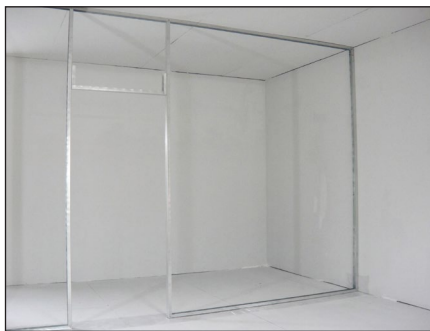
1. ปูพลาสติก ติดตั้งโครงคร่าวผนังโซลิด ด้วย 50 มม.
